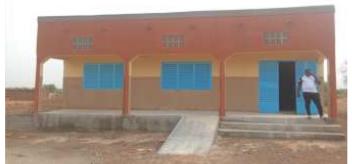
la première salle de classe de l'extension de Daguintoéga est prête pour la rentrée 2023-2024
