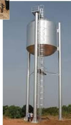
Château d'eau métallique de 10 m 3 et de hauteur sous radier de 10 mètres.
