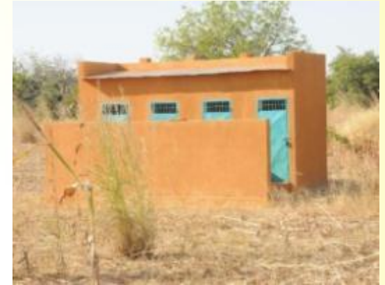
le nouveau bloc de latrines
