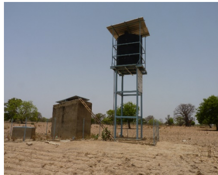
Le château d'eau rénové
