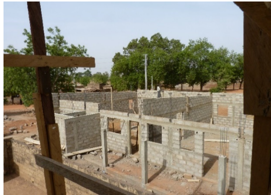
Chantier Salle des fêtes
