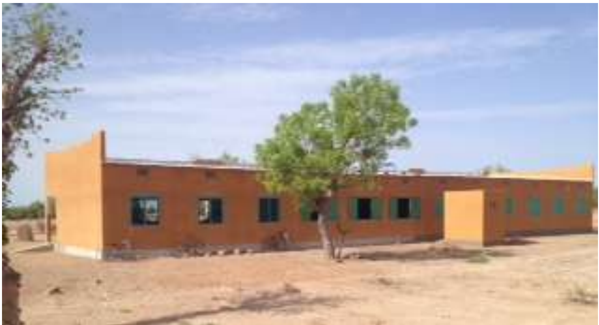
L'arrière du collège avec le petit bâtiment électrique
