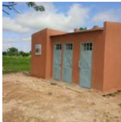
Latrines 4 cabines dont 1 handicapé
