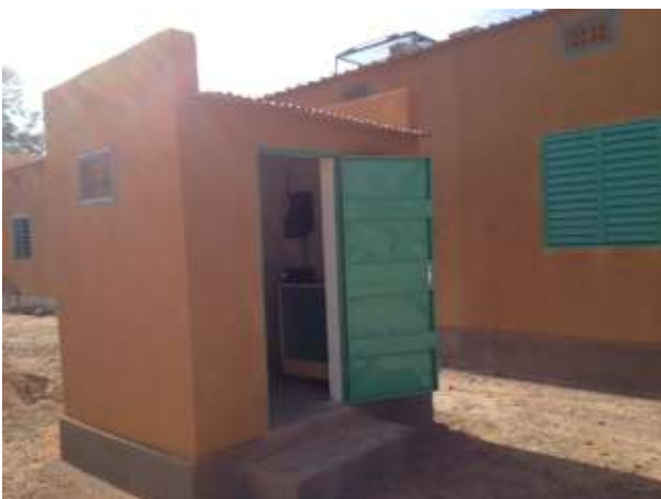
Local énergie où les batteries du collège ont été réinstallées
