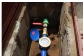
Compteur d'eau Collège
