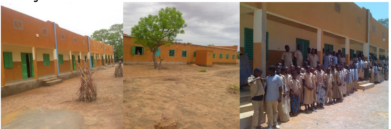
Le bâtiment des quatre classes du collège de Zinado, façade et arrière (avec local électrique), Des élèves des 2 sixièmes
