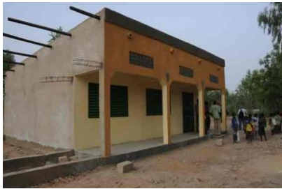
Construction de la classe de CP1 par Zinado 2000
