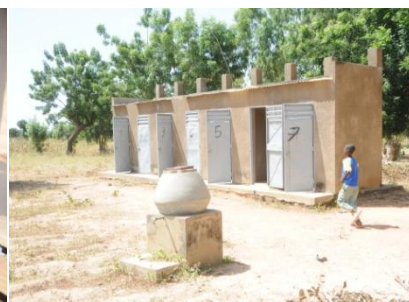
Latrines remises en état cet été
